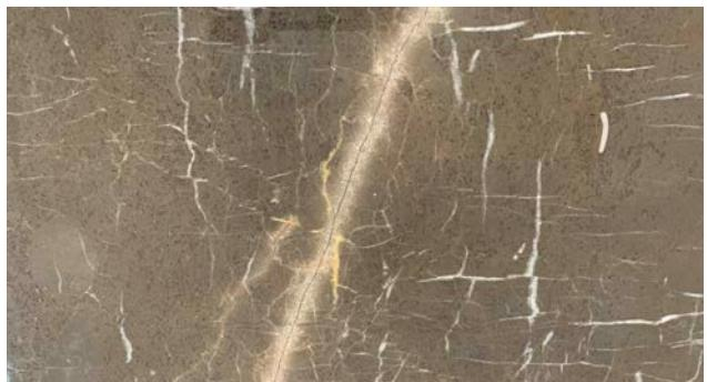
Fessure naturali livellate con resine | Natural cracks filled with resin | Naturröhren Sprünge mit Harz geebnet | Fissures naturelles comblées avec des résines | Fisuras naturales niveladas con resinas
